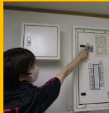
フレーカーも確認後切断
